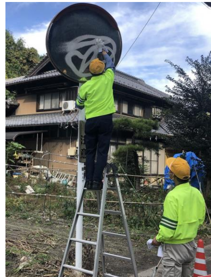
カーブミラー点検の様子
